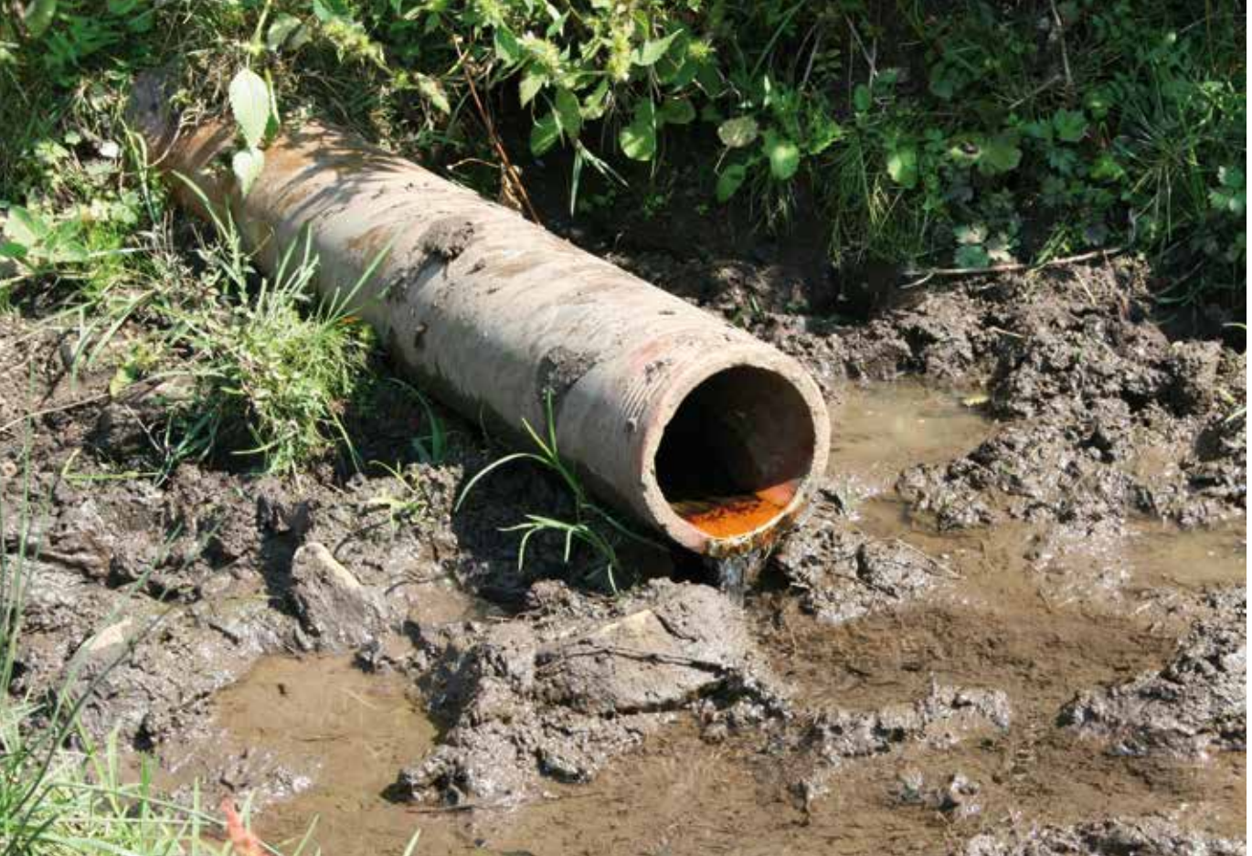
Verrohrung an der Strüttquelle 5 (Foto Stefan Zaenker)
