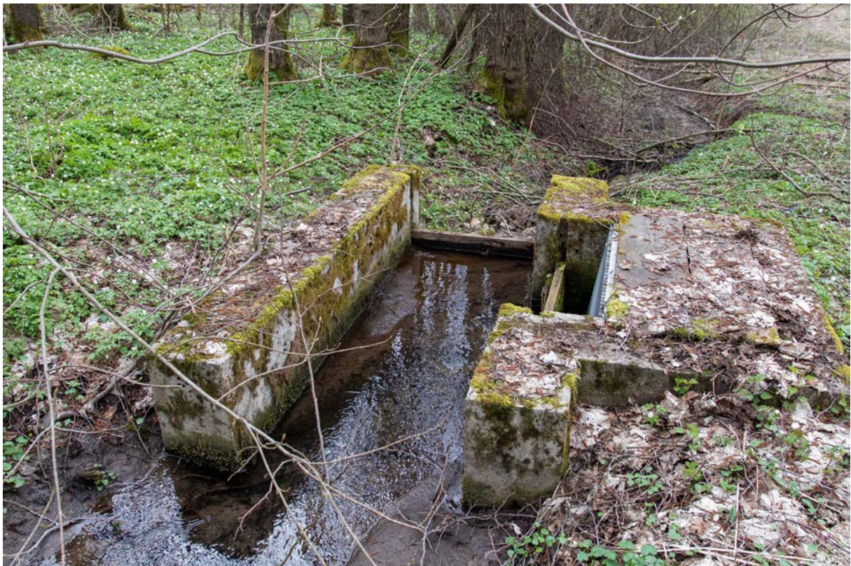
Abb.: Wasserentnahme im Quellbach oberhalb der Teichanlagen
