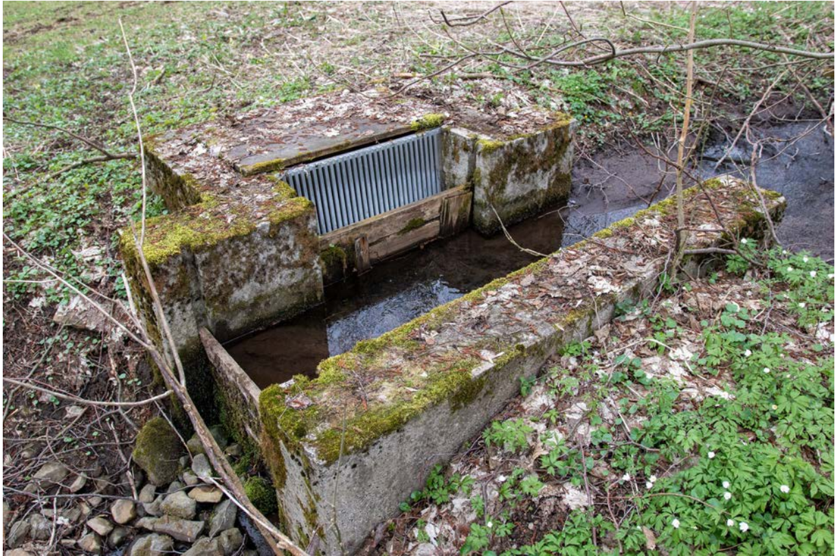
Abb.: Wasserentnahme im Quellbach oberhalb der Teichanlagen
