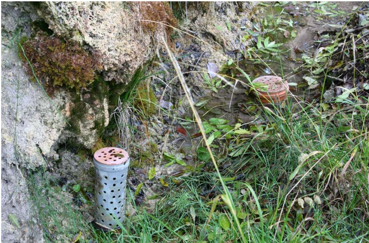
*Abb.: Drainagerohre unterhalb der Kalktuffbarriere*
