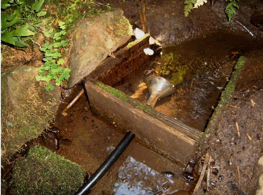
Abb.: Künstlicher Aufstau und Wasserentnahme im Quellbach der Rhönwald-Quellen
